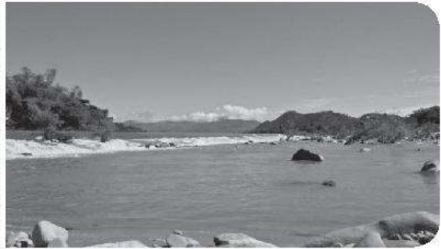
Hình 16.2. Đập Nha Trinh (Ninh Thuận)
